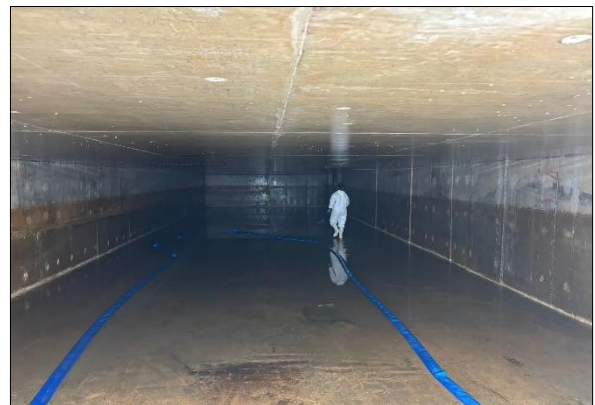
ภาพที่ 2-6 แสดงการล้างถังเก็บน้ำดีประจำปี
